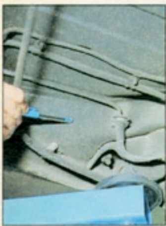
Auch die hinteren Hilfsrahmen bleiben von der Korrosion nicht verschont. Das gilt vor allem für Passat-Modelle der ersten Generation
